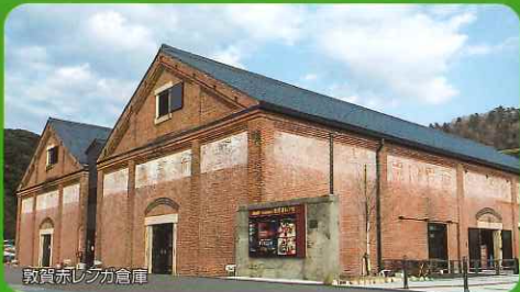
敦賀赤レンガ倉庫
